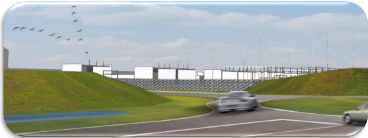
Impressie van het 150/20kV station, gelegen in het glastuinbouwgebied
