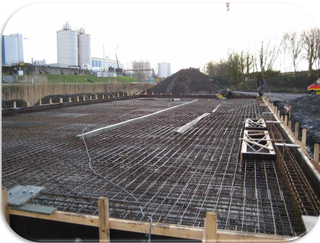
aanleg fundering gietwaterfabriek
