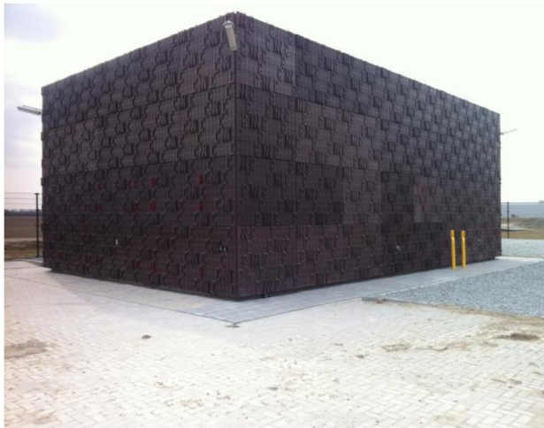
Gasontvangstation bedekt met biocomposiet gevel
