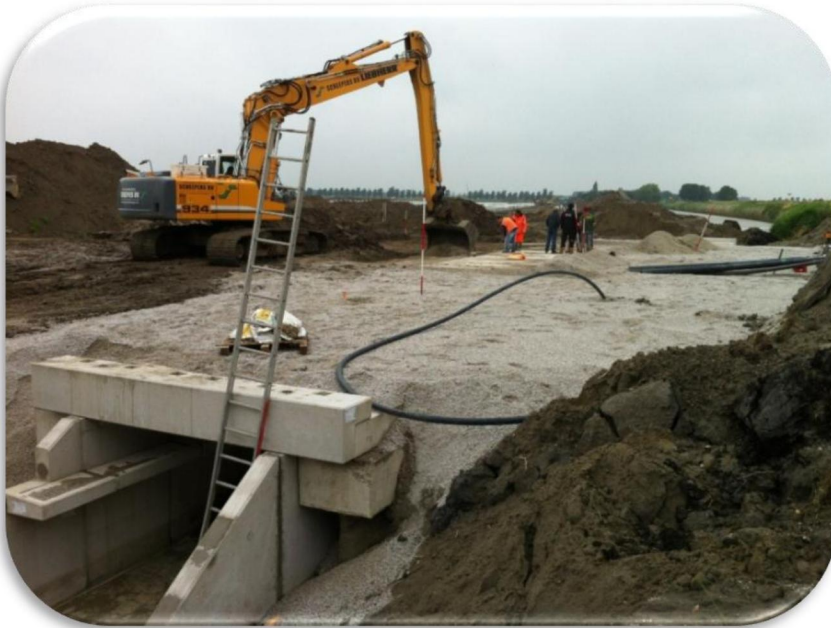
aanleg ecologische duiker in Derriekreek t.b.v. aansluiting Symbiose op Noordzeedijk
