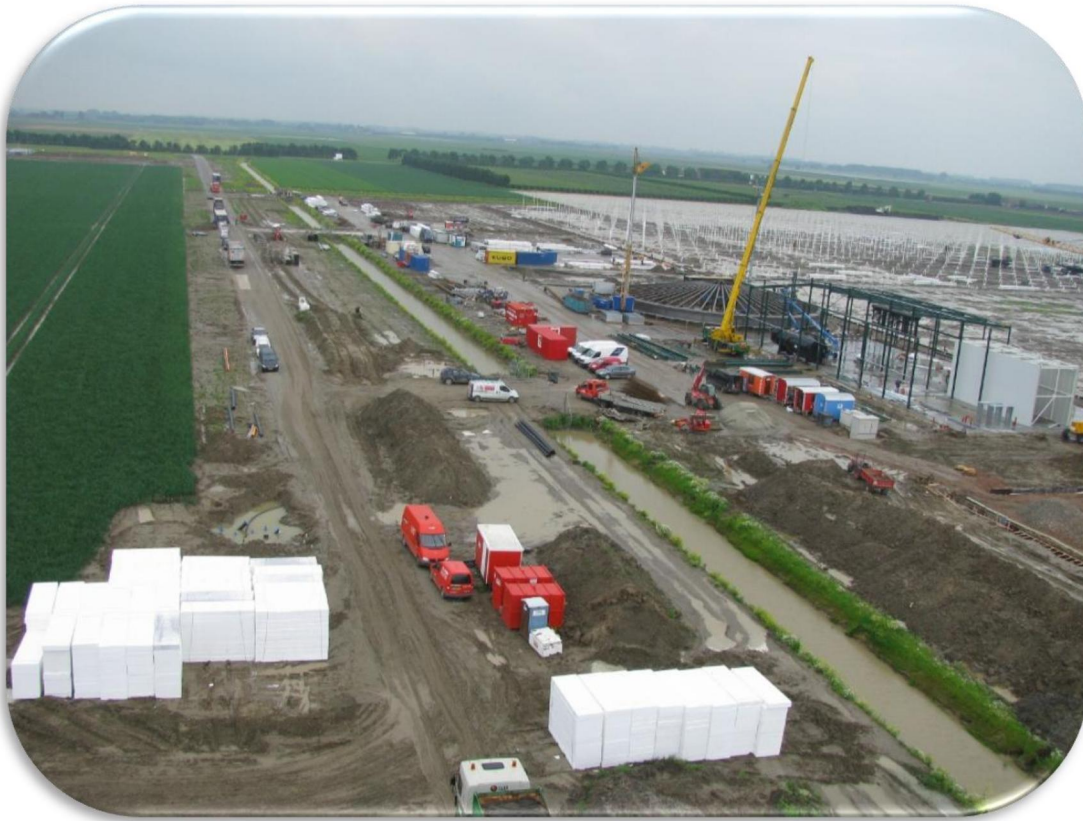
Aanleg kas van Redstar en de weg Symbiose in Nieuw Prinsenland
